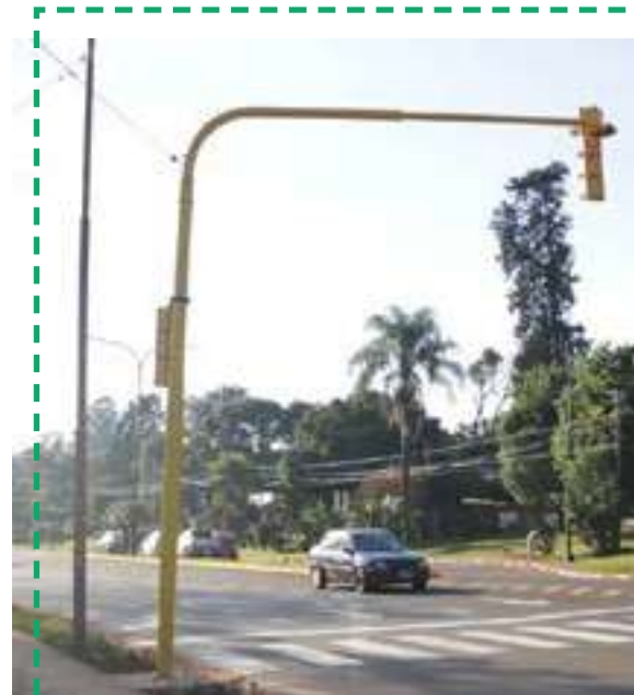
Instalación de CÁMARAS DE CONTROL VEHICULAR
